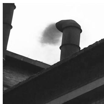
图 1 某 6240 电喷柴油机排气冒黑烟
