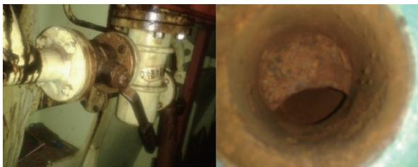
图2 泄放阀部分打开，阀芯锈蚀卡死
