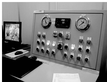
图 3 试验装置控制台
