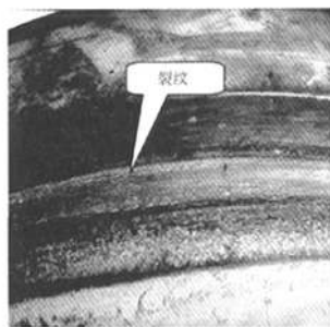
图2 故障件裂纹形貌
